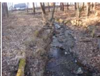
ため池の放水路
